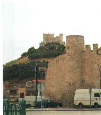
Restos de la muralla.
